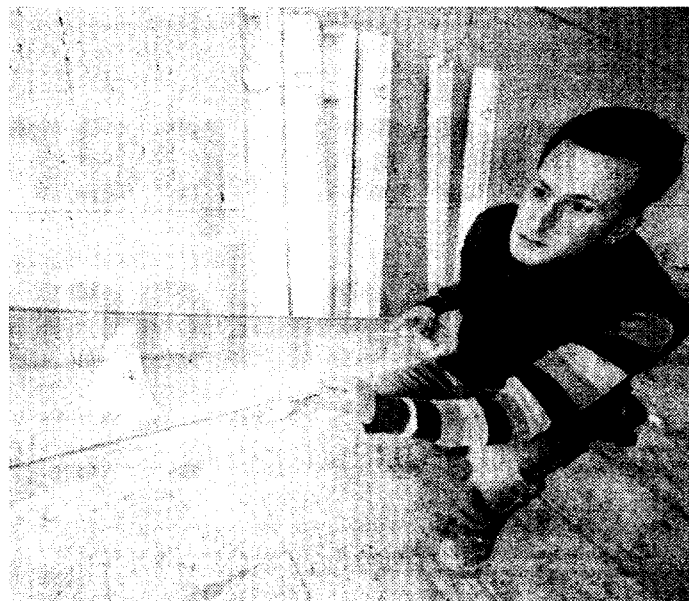
Un operaio della Spo al lavoro in un sottopasso della circonvallazione
